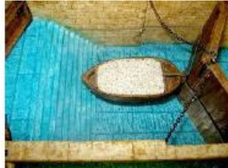
La chiusa si apre e fa passare la barca. Successivamente la chiusa si richiude e fa rialzare il livello dell'acqua.
