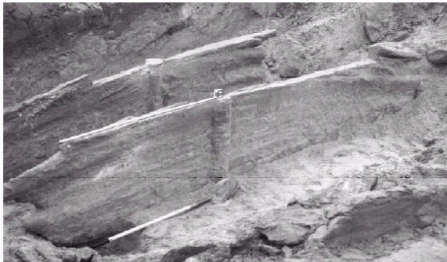
Figura 14 – Pannello sottile realizzato mediante Jet Grouting
