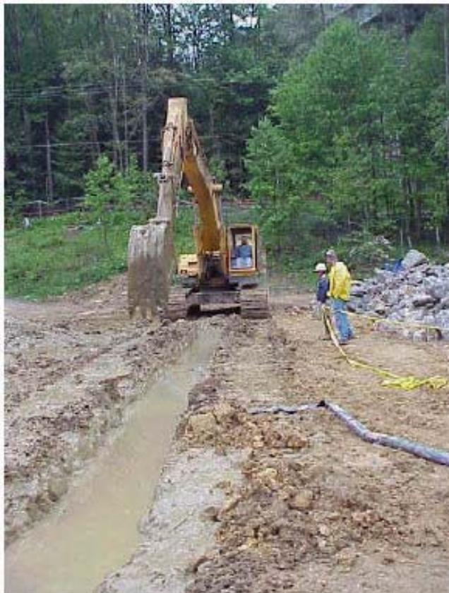
Figura 13 – Trincea per la realizzazione di un diaframma plastico
