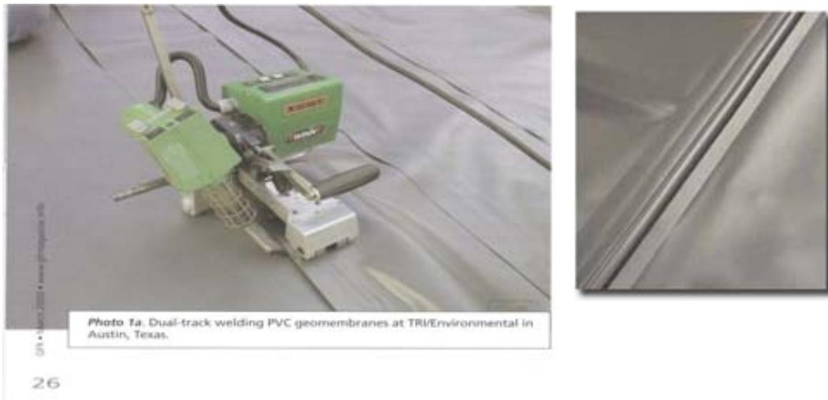
Figura 5 – Geomembrane: saldature a doppia pista
