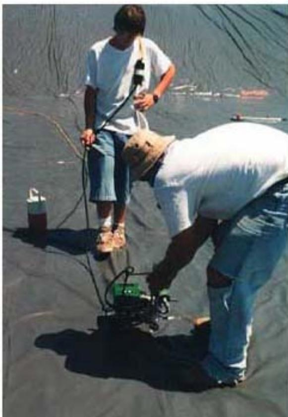
Per la finitura di angoli o zone in cui non si può ricorrere alla saldatura a cuneo caldo si può ricorrere alla saldatura per estrusione con materiale di riporto. In questo caso si sovrappone ai due teli del materiale di riporto, con identiche caratteristiche tecniche, saldato a caldo.
