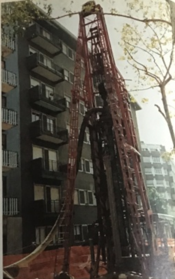
Acquedotto di Milano Perforazione nuovo pozzo in Via Conca del Naviglio
